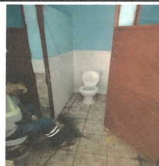
Levantado y revisión de sanitario por fuga en tubería.
