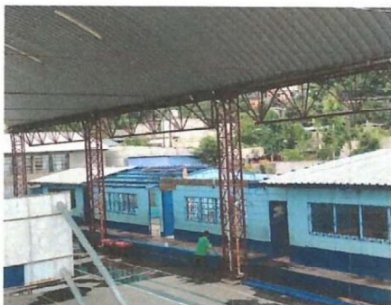
Techado de estructura metálica y cambio de doble agua a una línea.
