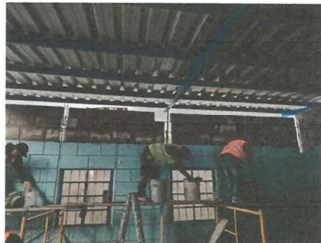
Nivelación de techo.
